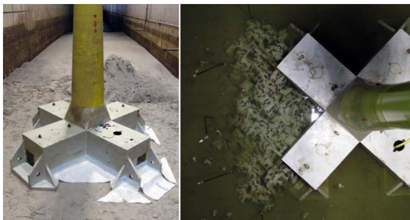
Abbildung 4: Fundament mit angebaute Vlies (links) und Fundament während der Einbauphase des Kolk- schutzsystems (rechts)
