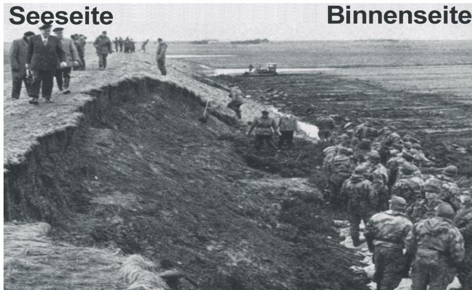
Abb. 6: Schaden an einem Seedeich nach Wellenüberlauf
