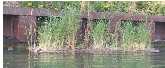
Abb. 2: Schilfgabionen nach Einbau im Mittellandkanal
