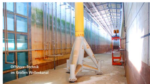
Abb. 2: Tripod-Fundament im Großen Wellenkanal
