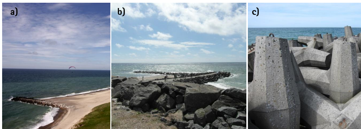
Abbildung 8: a) Buhnenfeld bei Ferring; b) Kombinierte Buhnenkonstruktion aus Betonelementen und Basaltsteinschüttung bei Thyboron; c) Buhnenarmierung mit Dolossen südlich von Thyboron
