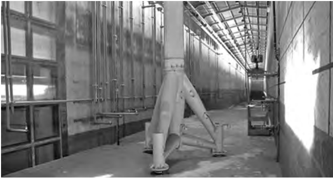
Abb. 2: Tripod-Fundament im Großen Wellenkanal
