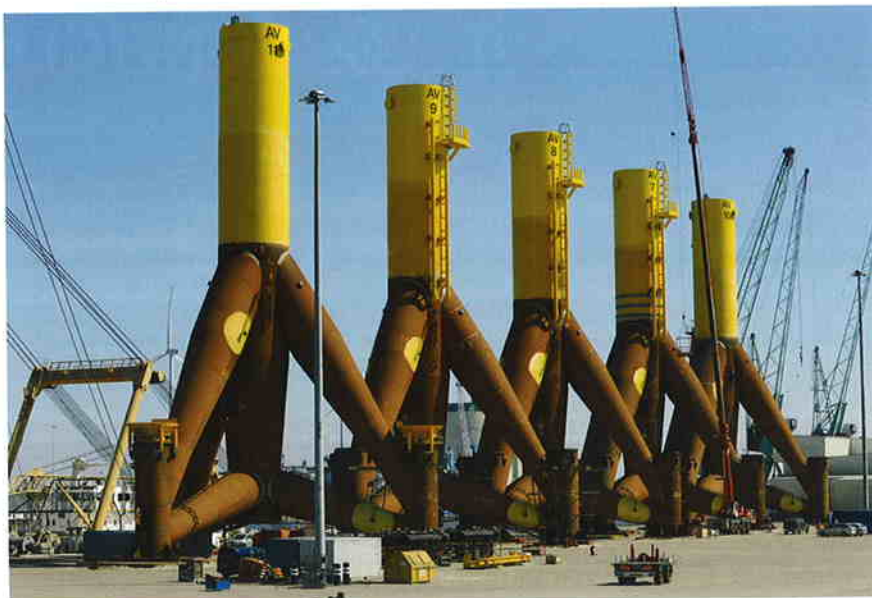
Vorbereiten von Tripod-Gründungen für Alpha Ventus in Eemshaven. Foto: Offshore Stiftung/Multibrid/Jan Oelker
