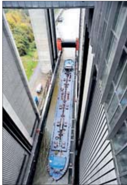
Zu eng: Das Hebewerk in Scharnebeck.
