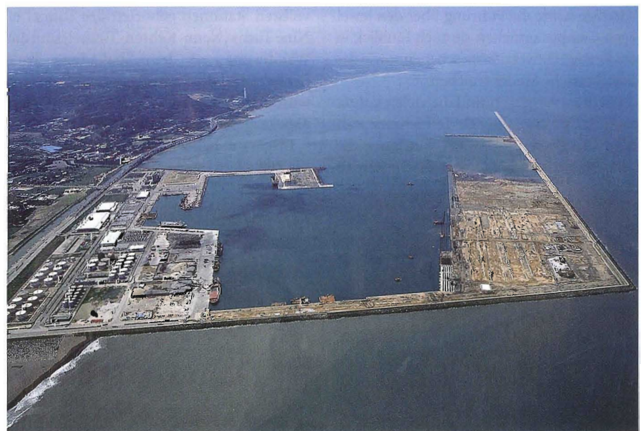
Abb. 5: Aufspülungsmaßnahmen für den Port of Taipei [3]
